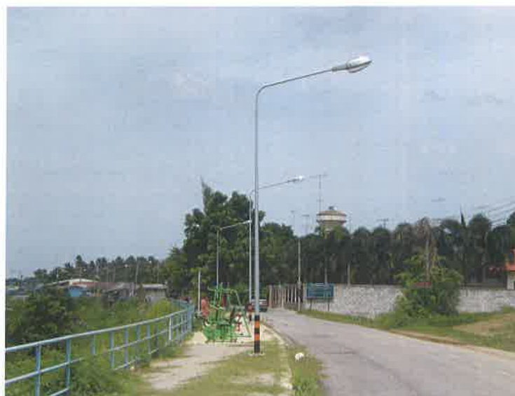
ลานกีฬาหมู่ที่ 8 บ้านท่าเสา บริเวณริมแม่น้ำแม่กลอง
